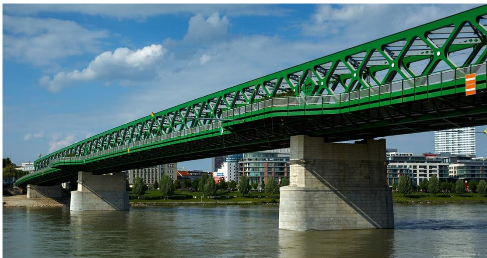
Obr. 1 Nová oceľová konštrukcia Starého mosta v Bratislave
