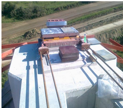
Obr. č. 10 dočasné ložiská/klzne bloky
