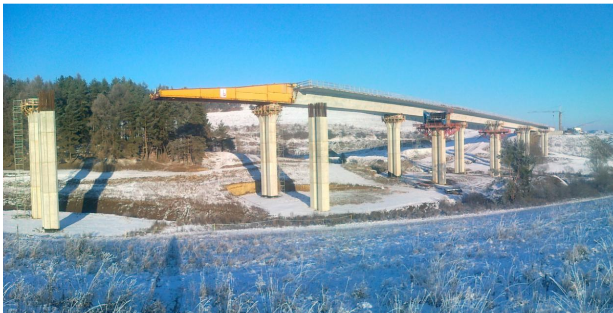
Obr. č. 1 pohľad na obj. 205 vo výstavbe
