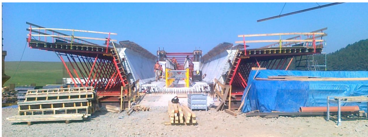
Obr. č. 7 foto výroby po betonáži 1.časti lamely
