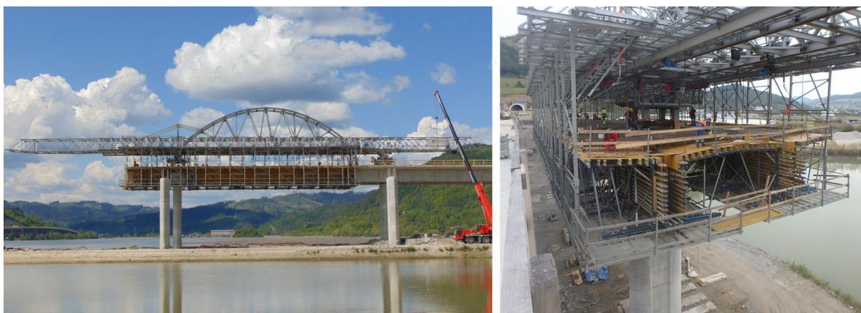
Obr.6 Fotografie z výstavby NK výsuvnou skružov BERD na TC4.
