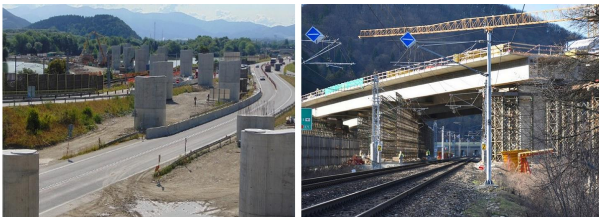
Obr. 4 Fotografie z výstavby TC1
