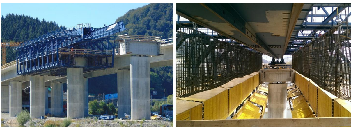
Obr.5 Fotografie z výstavby NK výsuvnou skružov Strukturas na TC2.
